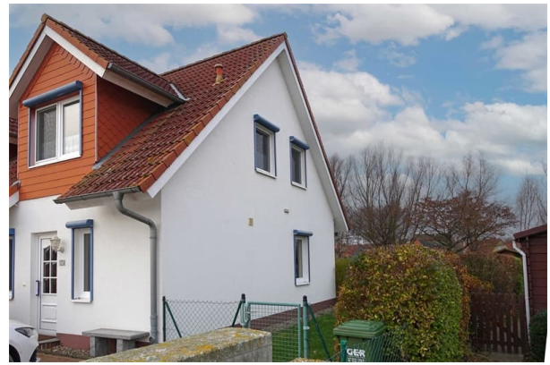
Ansicht von vorn
